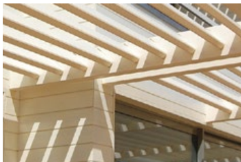
POUTRES ET LAMBOURDES
