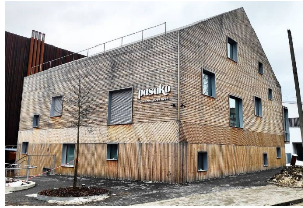
Année de construction 2020, photo 2021, Lituanie. L'orientation des façades peut influencer sur la progression du processus de grisonnement et sur la vitesse de son évolution. La couleur peut parfois devenir partiellement ou complètement noire. Les conditions d'humidité momentanée influent également sur le ton dominant des nuances.
