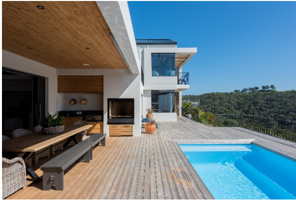
Année de construction, photo 2020, Afrique du Sud. Le processus de grisonnement a commencé. La couleur des planches les plus exposées aux rayons UV commence à s'estomper, avec parfois quelques différences entre elles. Cela est dû aux propriétés inhérentes au bois et à leur variation.
