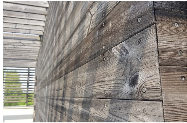
Année de construction 2009, photo 2019, Italie. Bien que le processus de grisonnement ait atteint son point final, il existe encore des variations de teinte de la surface en fonction de la variation des propriétés naturelles du bois.
