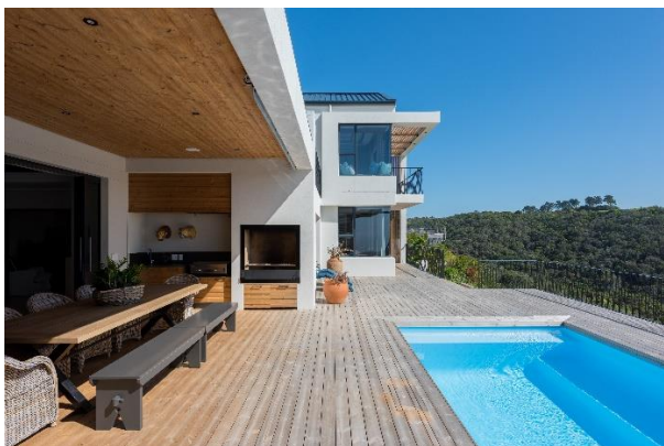
Année de construction, photo 2020, Afrique du Sud. Le processus de grisonnement a commencé. La couleur des planches les plus exposées aux rayons UV commence à s'estomper, avec parfois quelques différences entre elles. Cela est dû aux propriétés inhérentes au bois et à leur variation.
