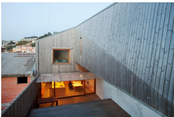
Année de construction 2015, photo 2019, Portugal. La surface a pris une belle teinte gris argenté. La partie du mur dans la zone ombragée a conservé son ton d'origine, tout en ayant légèrement passé.
