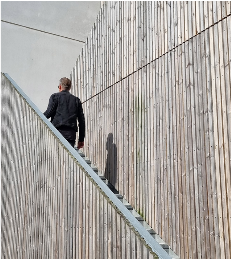
■ Himmelbyen, jossa on käytetty palosuojattua puuta. Kuva 2 vuotta asennuksen jälkeen. Arkkitehti: The Seasons Kuva: ©Bergsten Timber AS
