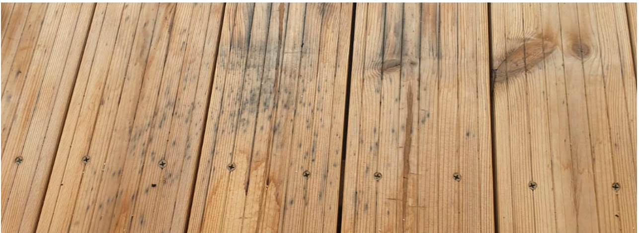
Unreinheiten können kleine schwarze Flecken auf der Oberfläche der Terrassendielen verursachen.
