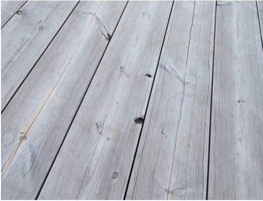
Unbehandelte Lunawood Terrasse (Thermokiefer) 2 Jahre nach Montage. Auf der Oberfläche sind kleine Haarrisse zu sehen.
