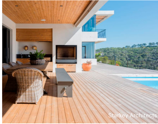
Terrasse eines Privathauses in Südafrika. Der Terrassenbelag im sonnigen Bereich ist im Vergleich zum schattigen Bereich schneller vergraut.
