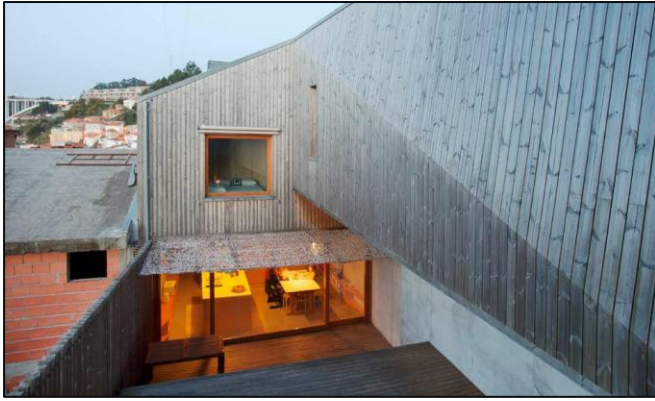
Neubau 2015 in Portugal, Foto aus dem Jahr 2019: Das Holz hat eine schöne silbergraue Patina. Der beschattete Teil der Wand hat seine ursprüngliche Farbe behalten, die jedoch etwas verblasst ist.
