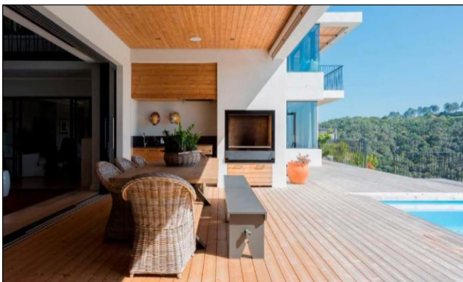
Año de construcción 2020, Sudáfrica. El proceso de envejecimiento ha comenzado. Las láminas más expuestas a la radiación UV son las primeras en empezar a decolorarse. Algunas de forma muy desigual. Esto se debe a las propiedades inherentes de la madera y sus variaciones.
