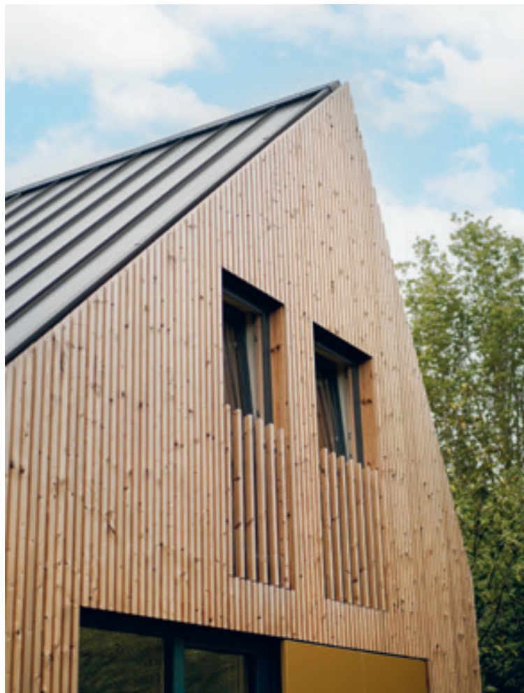
VB56 House, Hollanti. Arkkitehti: VANBOOM. Kuva: Chloë Alyshea.
