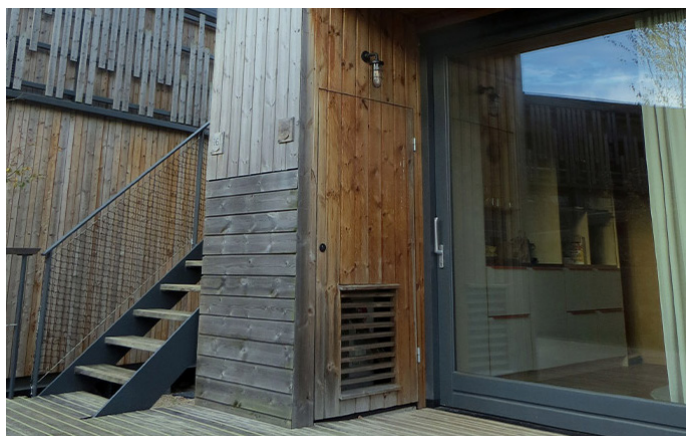
Revestimiento en los Países Bajos dos años después de la instalación. La orientación del edificio afecta la evolución del proceso de agrisamiento. A veces, el color puede parecer parcial o completamente negro. Las condiciones de humedad también pueden influir en el tono predominante.
