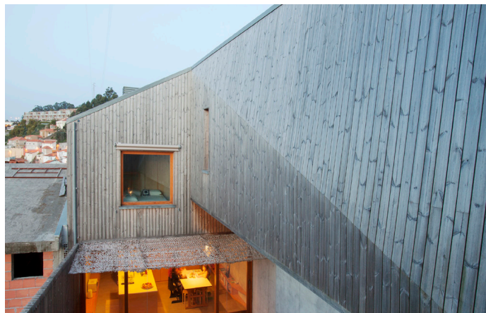
Revestimiento en Portugal 4 años después de la instalación. La superficie ha adquirido un hermoso tono gris plateado. ©Tiago Casanova
