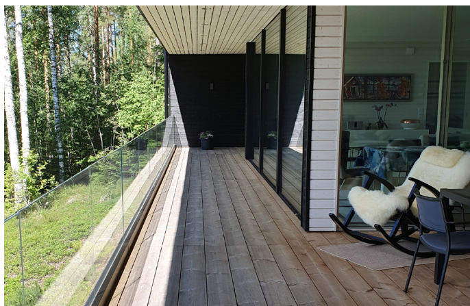
Tarima Lunawood, 2 años después de la instalación. La zona expuesta al sol se ha vuelto gris más rápidamente que la zona sombreada.
