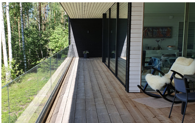
Lunawood-Terrassendielen 2 Jahre nach der Installation. Der Terrassenbereich in der Sonne ist im Vergleich zum schattigen Bereich schneller vergraut.
